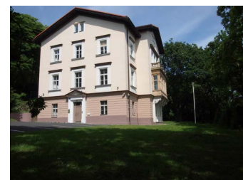
Usedlost Flajšnerka, nové sídlo společnosti HPST, s.r.o.
